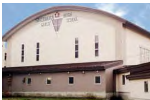
スポーツ設計の高校第一体育館
